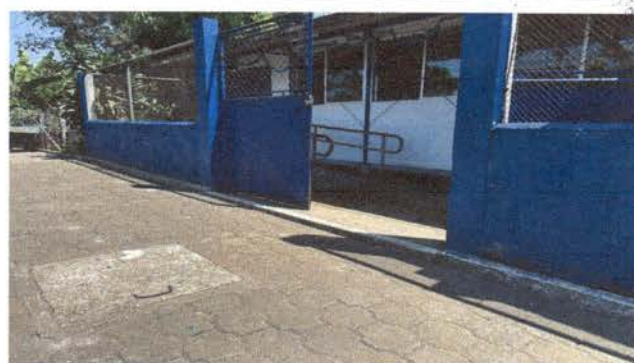
Foto 4: Reparación de muro perimetral por fuera.
