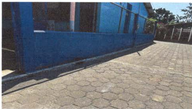
Foto 3: Reparación de muro perimetral dentro.
