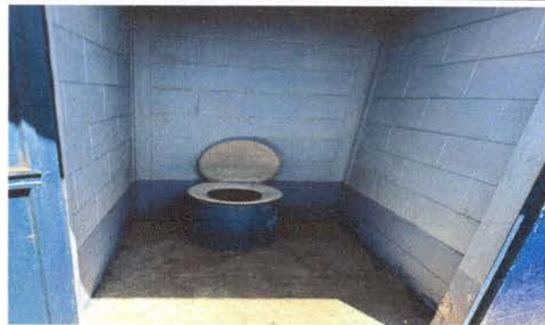
Foto 2: sustitución de fosas septicas por inodoros lavables.
