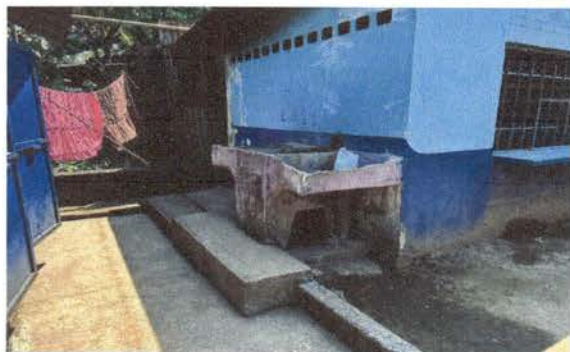
Foto 5: Sustitución de pila de dos lavaderos.
